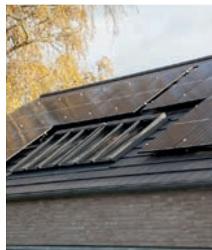
Aufdach-PV: Installation der PV-Module auf der Dacheindeckung.
