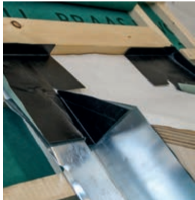
Übergang Abdichtungsfläche zum seitlichen Anschlussblech.
