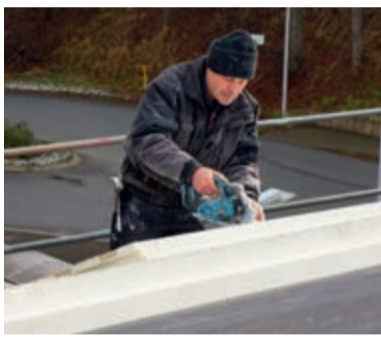
Zuschneiden des PU-Dämmelementes mit zwei oberflächenbündig und wasserfest verklebten Einlagen aus 110 x 22 mm großen Mehrschichtholzleisten.
