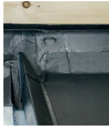
Nachdem die Verbundblechstöße mit Zuschnittstreifen aus Wolfin IB verschweißt wurden, folgt die Abdichtung der Gaubendachfläche mit Wolfin M. Die Übergänge der Organgprofile zu den Anschlussblechen werden ebenfalls mit Wolfin IB-Zuschnitten ausgeführt.
