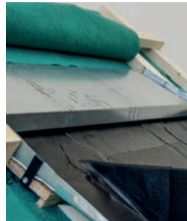
Einbau des Traufblechs zur Ableitung des Wassers von der Zusatzmaßnahme unterhalb der Dacheindeckung auf die Abdichtungsfläche.
