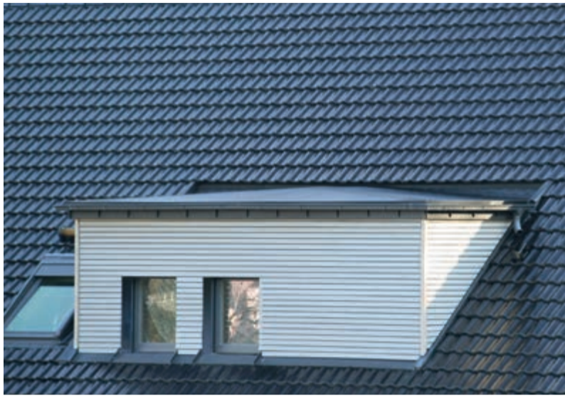
Herausforderung ist der Übergang vom Steildach auf die Gaube. © Fotos: BMI
