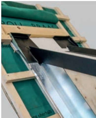
Herstellen der Organgprofile aus Wolfin Verbundblechen an den Dachrändern (Traufe, Organg und Dachknick zum Steildach) und Anpassung an die zuvor eingebauten Anschlussbleche.
