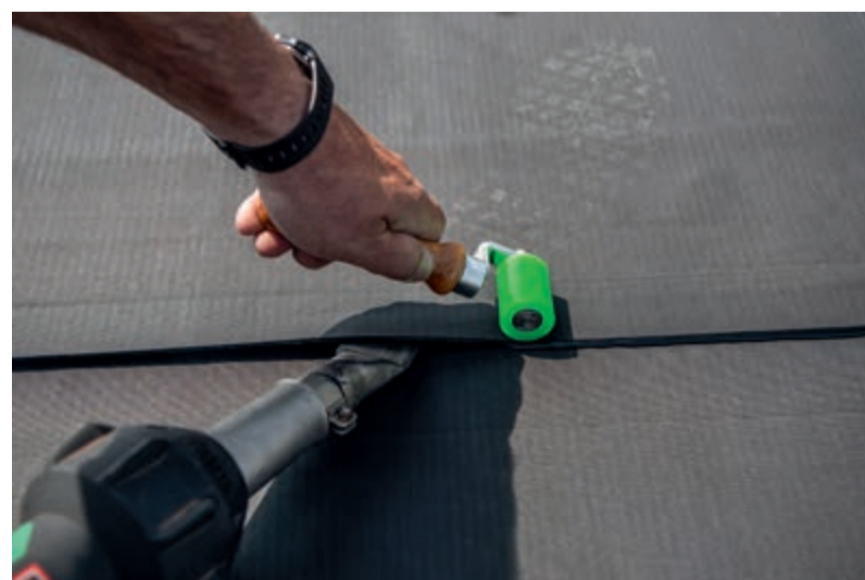
Die Nahtfugung der RESITRIX® Abdichtungsbahnen erfolgt sicher per Heißluft – mit dem Schweißautomaten oder einem Handföhn. Der Austritt einer gleichmäßigen Schweißbraupe dient hierbei als optische Kontrolle.
