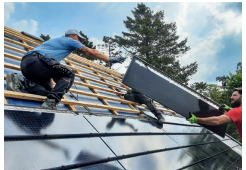
Das Braas Photovoltaik-Indach-System PV Premium besticht – neben der Erzeugung von Solarstrom – mit einem harmonischen Deckbild.
