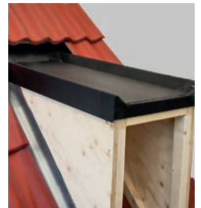
Fertig eingedeckte Steildachfläche mit fachgerechtem Anschluss an die Flachdachgaube.
