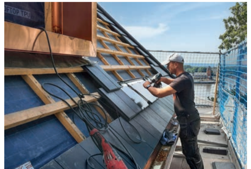
Das Braas Photovoltaik-Indach-System PV Premium besticht – neben der Erzeugung von Solarstrom – mit einem harmonischen Deckbild.
