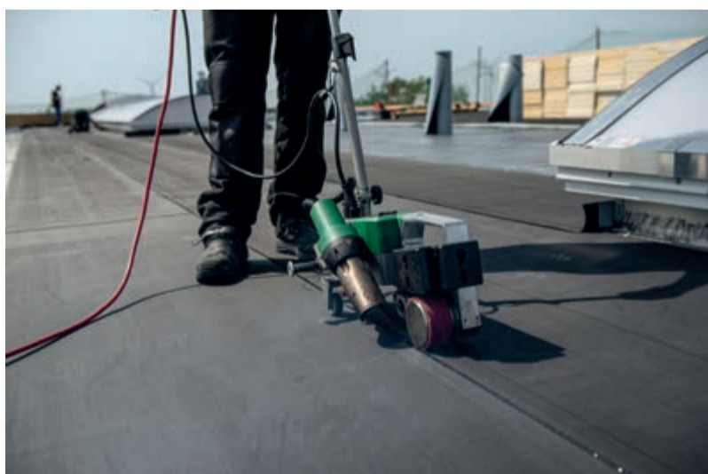
Die Nahtfugung der RESITRIX® Abdichtungsbahnen erfolgt sicher per Heißluft – mit dem Schweißautomaten oder einem Handföhn. Der Austritt einer gleichmäßigen Schweißbraupe dient hierbei als optische Kontrolle.
