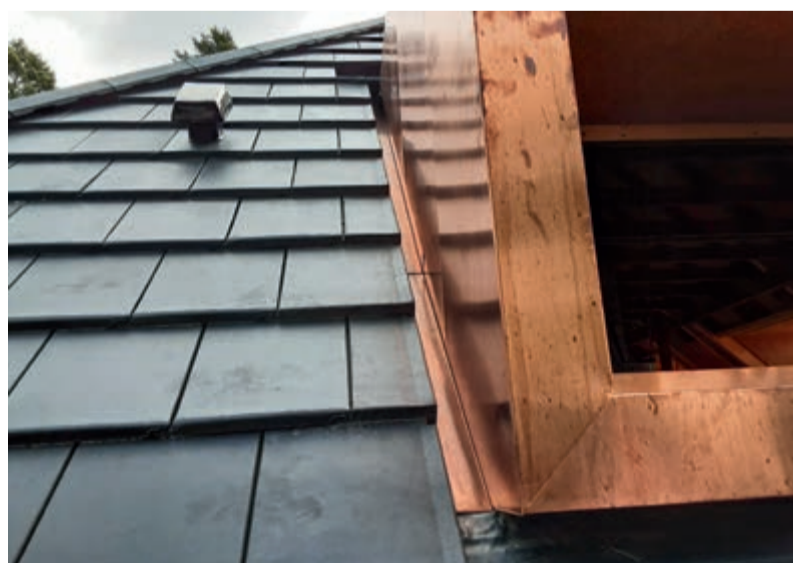
© Fotos: Frahm Haustechnik
