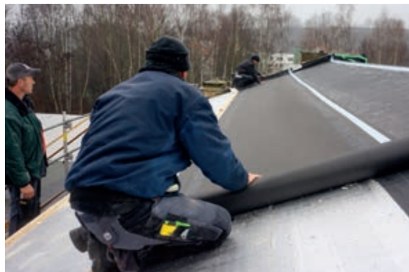
Um über die Wintermonate hindurch die Konstruktion vor Feuchteeintrag zu schützen, verlegten die Dachdecker oberhalb der Dämmebene erneut eine Notabdichtung und fixierten diese zusätzlich mit Dachlatten.
