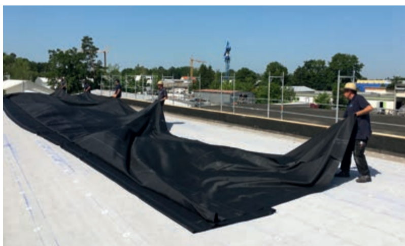
Die Direktsanierung mit HERTALAN® EPDM-Planen auf PVC-Alt-dächern ist ohne Demontage und Entsorgung möglich – das spart Zeit und Geld.
