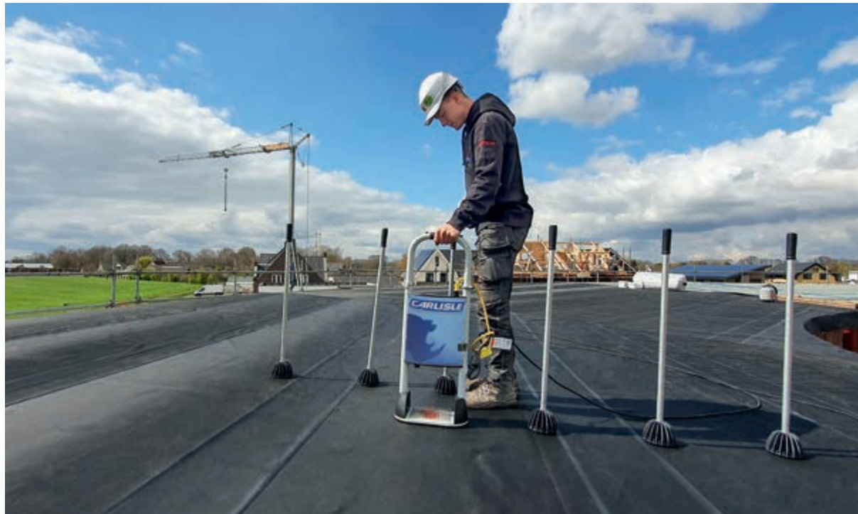
Dachabdichtungen aus HERTALAN® EPDM-Planen sind ideal für Projekte, bei denen nachhaltiges und zirkuläres Bauen im Vordergrund stehen – wie hier beim Ökodorf Boekel in den Niederlanden. © Fotos: Carlisle
