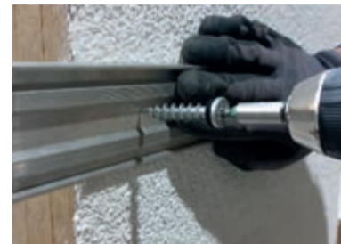
Die Isolierplattenschraube IPSZ bohrt sich dank der scharfen Bohrspitze direkt durch den Putz und durch dünne Bleche.
