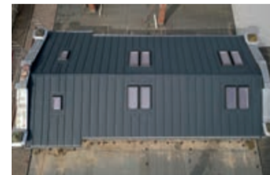
Blick auf das fertiggestellte Dach.
