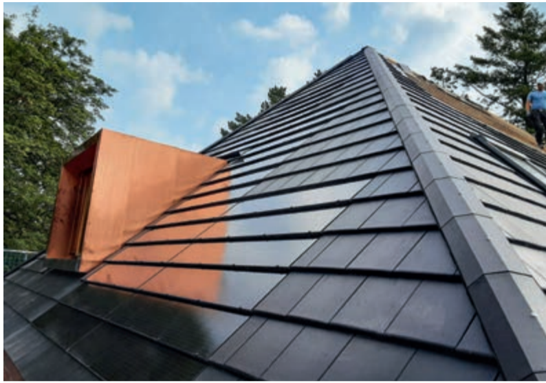
Klempnermeister Dennis Frahm und sein Team deckten ein 280 m 2 großes Walmdach mit einem Photovoltaik-Indach-System ein – Blick auf die Elbe inklusive.
