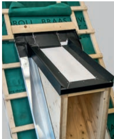
Herstellen der Organgprofile aus Wolfin Verbundblechen an den Dachrändern (Traufe, Organg und Dachknick zum Steildach) und Anpassung an die zuvor eingebauten Anschlussbleche.
