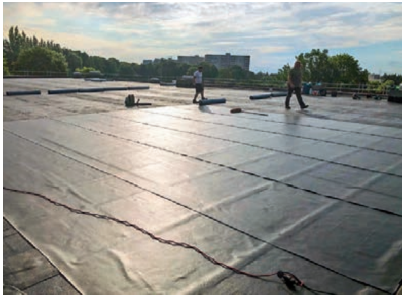
Sanierung eines feuchtebelasteten Altdachs mit Wolfin: Wasserwerk Tegel der Berliner Wasserbetriebe: 1. feuchte Dämmung auf dem (in diesem Fall) Betonuntergrund weiter nutzen, 2. alte Abdichtung perforieren, 3. Zusatzdämmung aufbringen, 4. mit der Wolfin-Sanierungsbahn abdichten. 5. Dann startet ...
