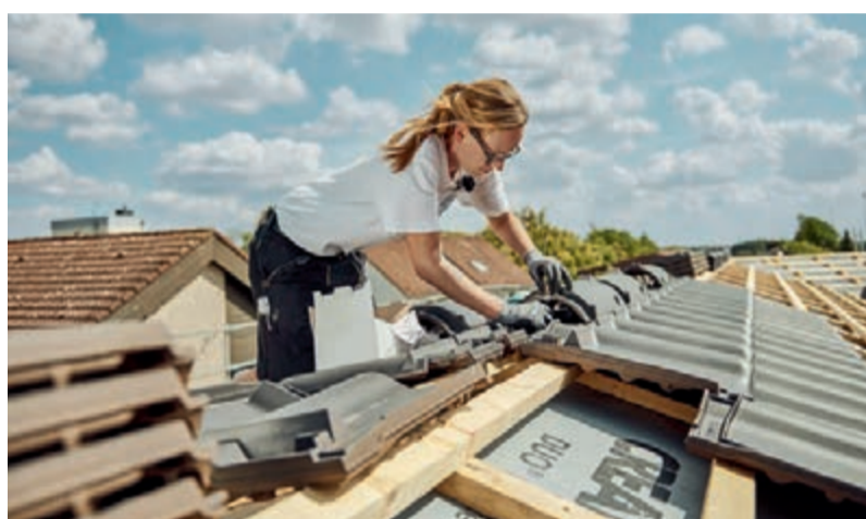
Mit dem Firstfix-System ist die Eindeckung des Firsts kinderleicht.
