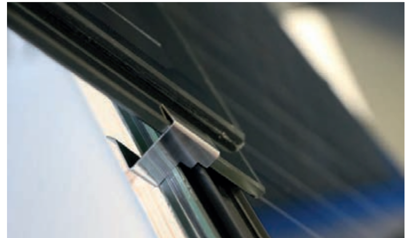
Windsogsicherung von PV-Modulen mit einer PV-Seitenfalzklammer.
